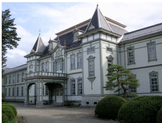
キャンパス内正門付近に建つ旧米沢高等工業学校本館（重要文化財）
